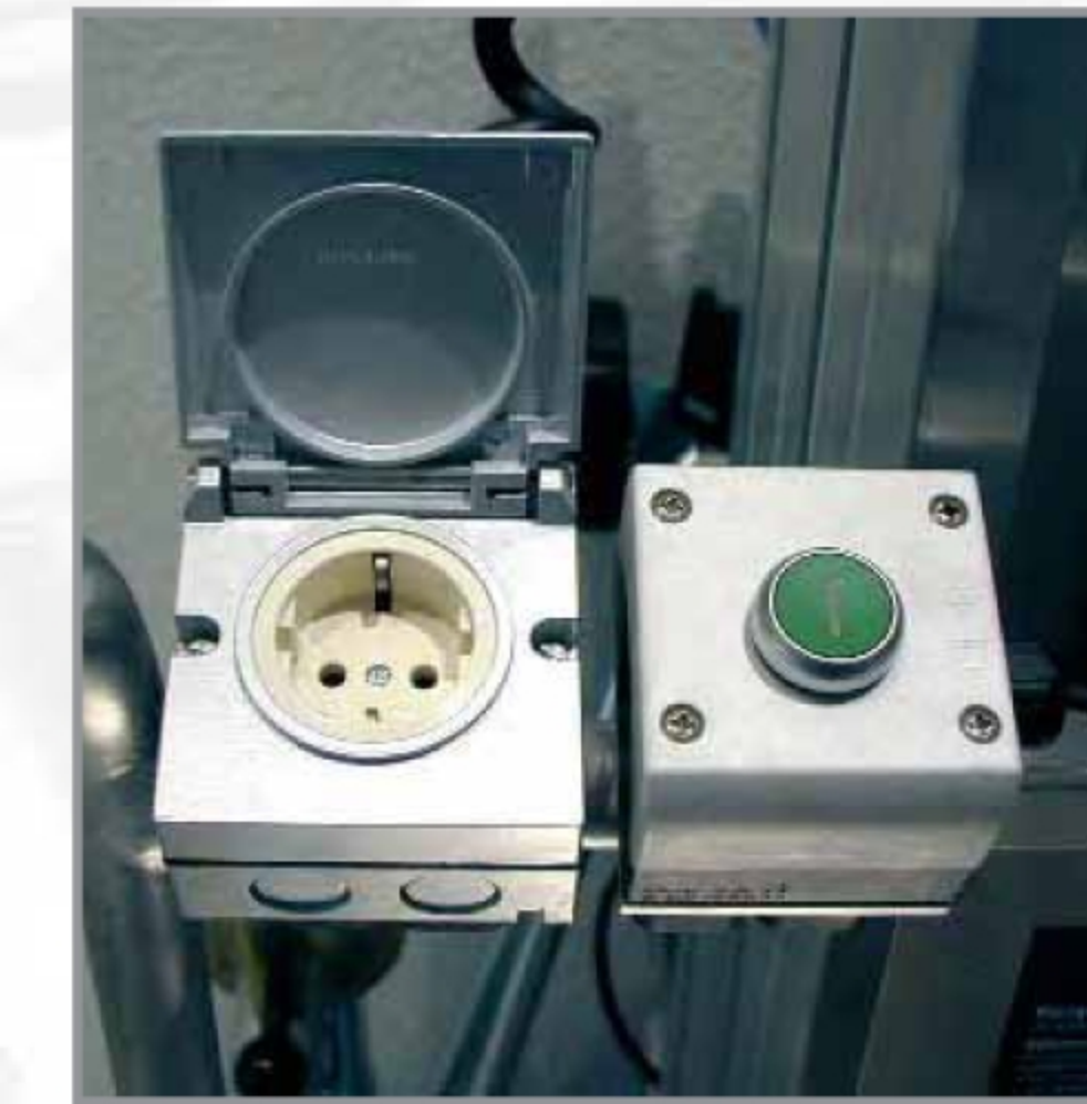
Stromversorgung im Arbeitskorb
